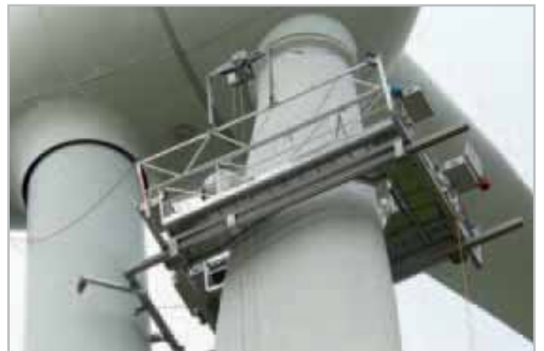
Foto: Seildurchlaufwinde im Einsatz
